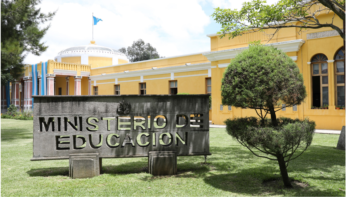
Instalaciones del Ministerio de Educación. 2018. MINEDUC
